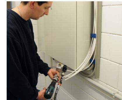
einer sehr anspruchsvollen, 150 m langen Indoor-Teststrecke mit insgesamt 36 Bögen, davon 12 mit minimalem Biegeradius von 10xD, werden die verschiedenen Kabel mit modernster Einblasttechnik von Vetter installiert.
