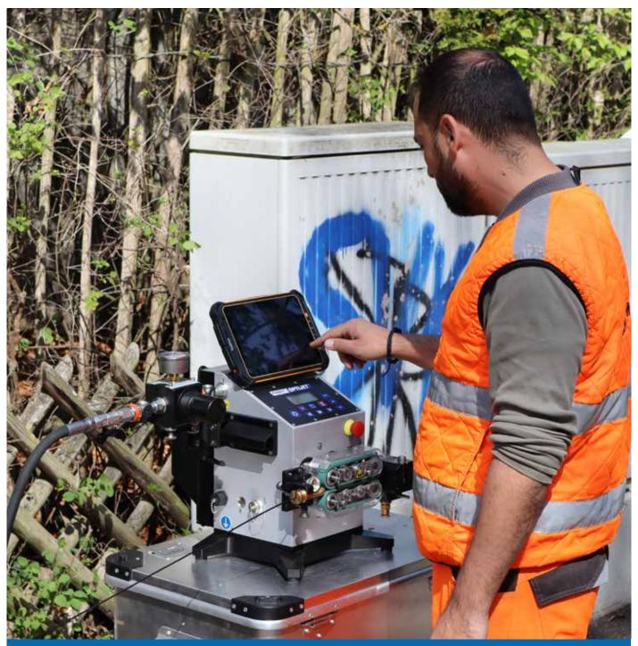
Der neue OptiJet™ ist ein leistungsfähiges, intelligentes und zukunftsweisendes Einblassystem, welches neue Maßstäbe beim Einblasen von Glasfaser-Mikro- und Minikabeln, sowie Bündelfasern setzt.
